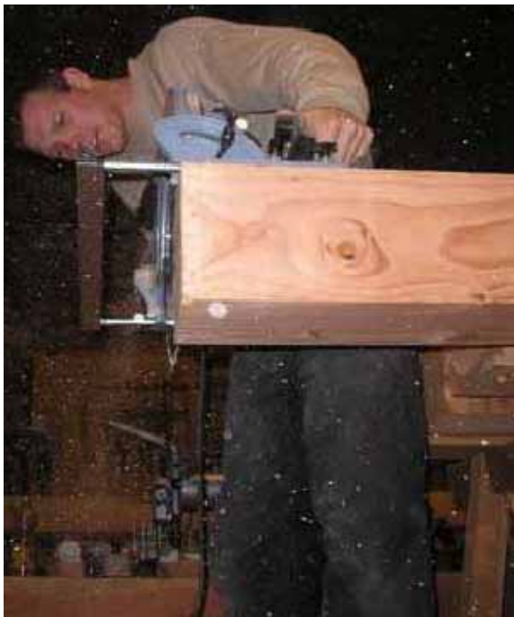
Taille des poteaux de 18 x18 avec la circulaire d'une capacité de coupe de 16.5 cm
