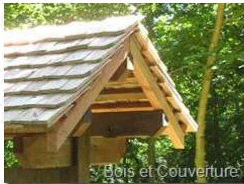
Il s'agit d'une planchette en bois qui permet de couvrir les toitures ou les murs, avec le même types de pose que l'ardoise.
