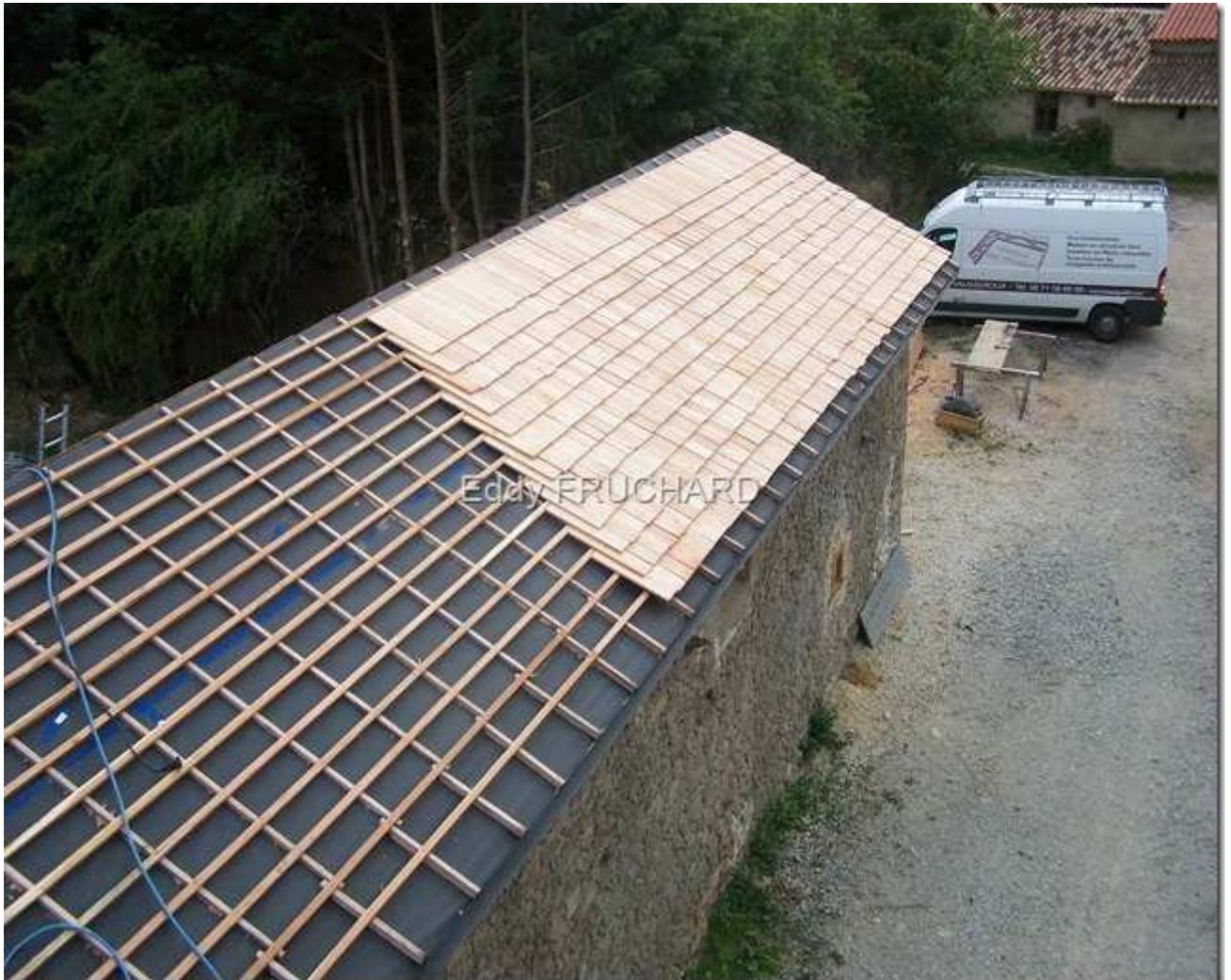
La pente minimum pour la pose des bardeaux doit être de 30 ° minimum
